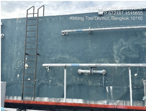
รูปที่ 12 ถังสำรองน้ำชั้นดาดฟ้า
