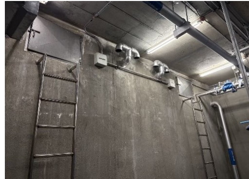
รูปที่ 13 ถังสำรองน้ำใต้ดิน
